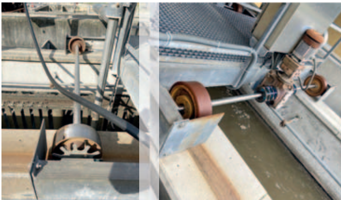
Pumpwerk Saubachtalweg - Räder des Sandfangräumers vor und nach der Reparatur
