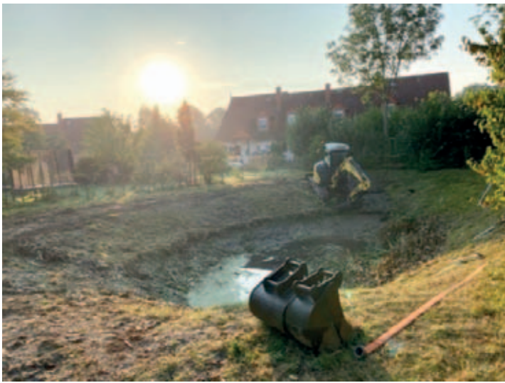
Beräumtes und neu abgedichtetes Regenklärbecken Nr. 7 in Grumbach
